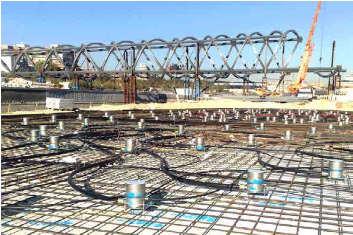
PUENTE SOBRE M-30 PARA DRAGADOS (MADRID)
