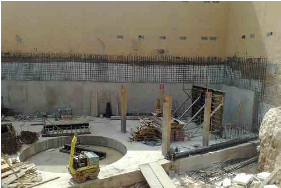
PARKING SOTERRADO Y VIVIENDAS DE LUJO PARA ARCION (VALENCIA)
